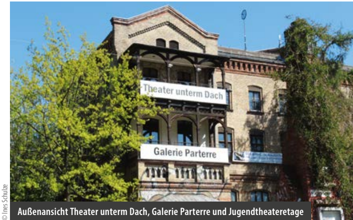
Außenansicht Theater unterm Dach, Galerie Parterre und Jugendtheateretage
