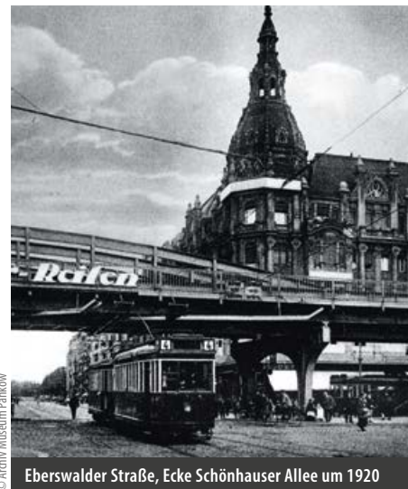
Eberswalder Straße, Ecke Schönhauser Allee um 1920
